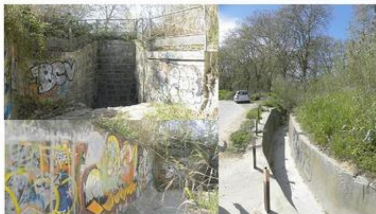
Vues diverses de l'aqueduc actuellement.
